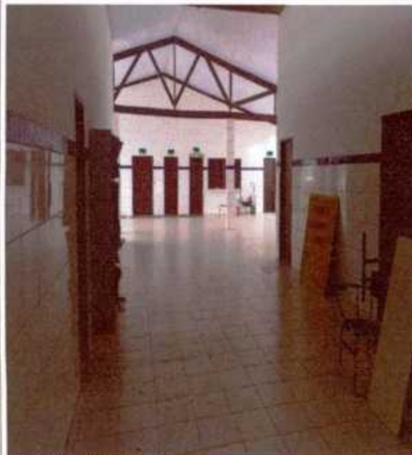
Piso em Bom Estado
