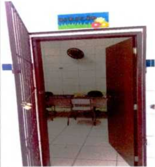
Secretaria com Portas, paredes, Piso, iluminação em Bom Estado
