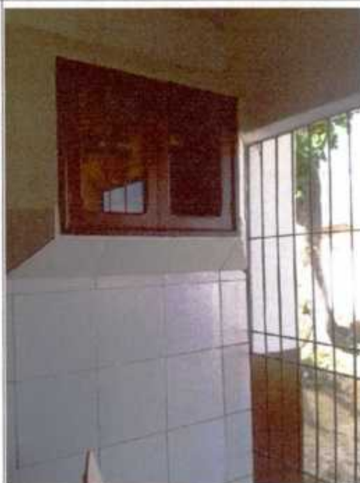
Figura 08: Repor vidro em quadro de disjuntores
