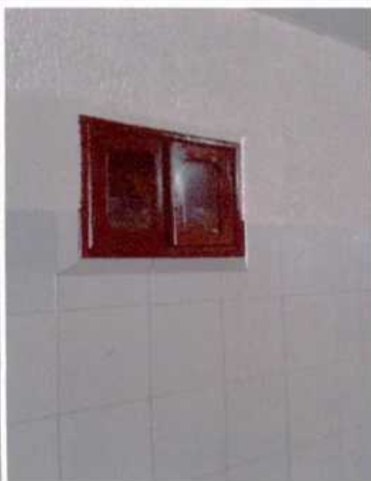
Figura 15: Revisão das instalações elétricas
