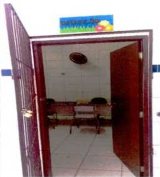
Secretaria com Portas, paredes, Piso, iluminação em Bom Estado
