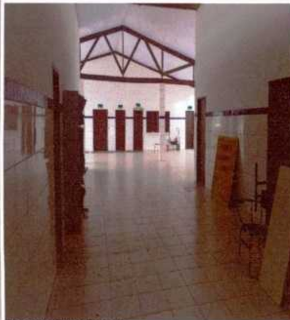
Piso em Bom Estado
