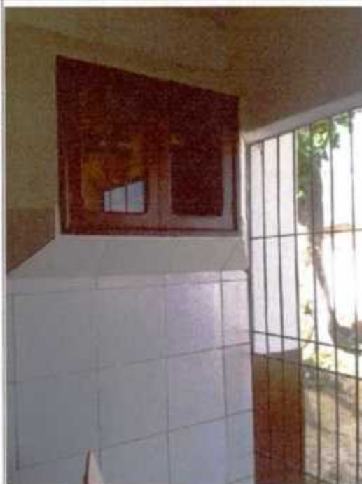
Figura 08: Repor vidro em quadro de disjuntores
